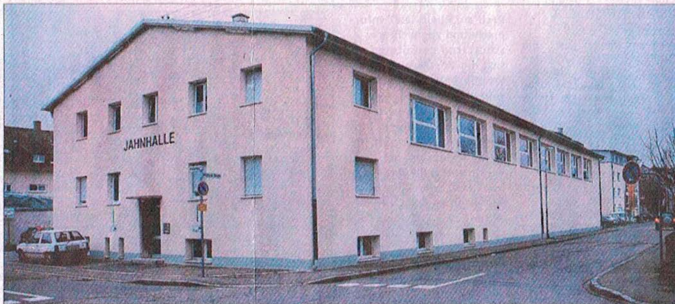
Die Jahnhalle erstrahlt nach umfassender Sanierung in neuem Glanz.
