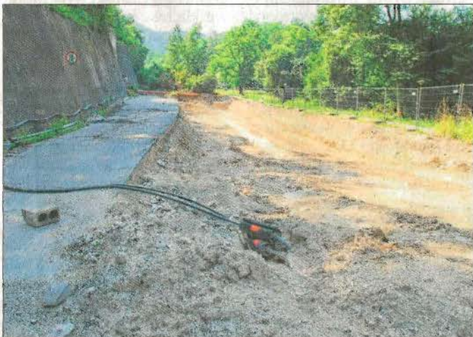
Die Zufahrt zum Tunnel wird angepasst.
