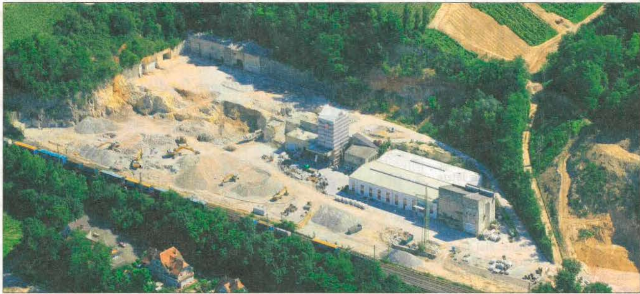
Mehrere Baumaschinen sind nach wie vor im Einsatz auf der Abbruchbaustelle in Kleinkems.
