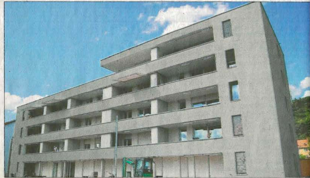
Der bereits fertig gestellte erste Bauabschnitt der Baugenossenschaft Grenzach im Jericho in Grenzach. Foto: Heinz Vollmar
